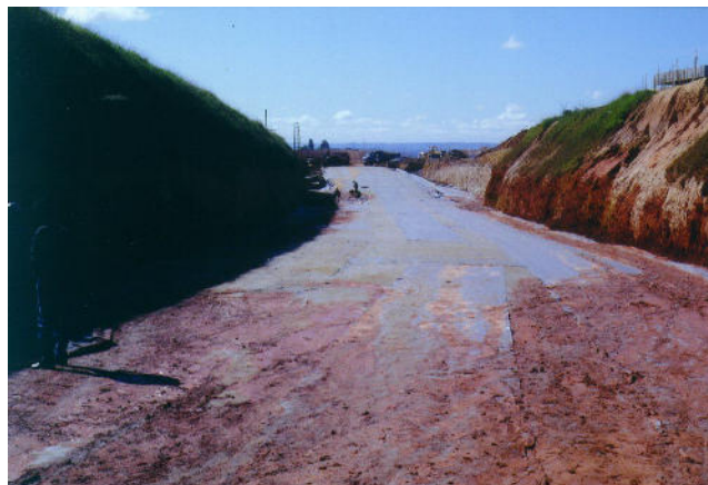
Impregnación del geotextil...
