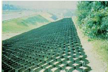
Geoceldas rellenas con concreto
