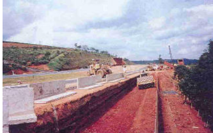
Face con piezas de hormigón prefabricado
