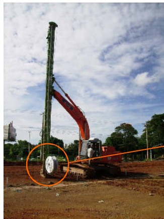
Instalación de Geodrenes – Viaducto de Acceso a Águas Claras
