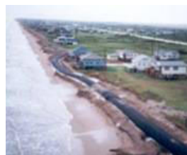
Dique de protección
