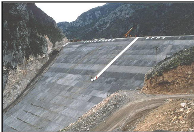
Restauración de la Presa de Bovilla, Albânia (H = 91 m)
