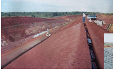
Canal de aducción – Presa AHE Itiquira, MT (4,8 km - 250.000 m 2 ) Colmanetti (2006)
