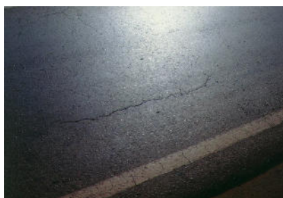
Repavimentación con geotextil
