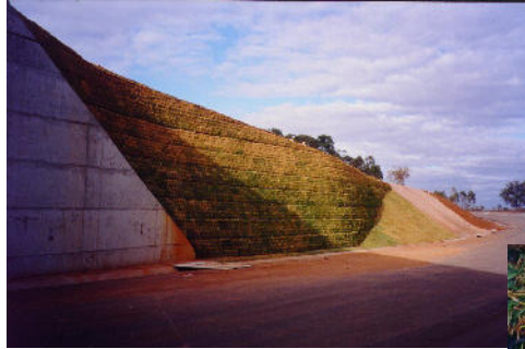
Viaducto de lo Aeropuerto de Brasília, DF, Brasil
