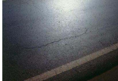
Repavimentación con geotextile
