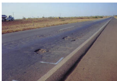
Repavimentación sin geotextil
