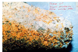
Muestra de drenaje granular exhumado de un sistema de recolección de lixiviado después de 4 años en servicio (Fleming et al. 1999)
