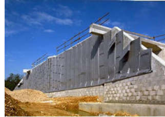
Geocompuesto detrás de muro de contención (Foto: Cortesía de J.P. Gourc)
