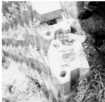
Face con bloques prefabricados "Segmental Retaining Walls"
