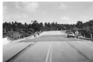
Restauración del pavimento
