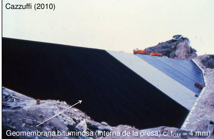
Presa de L'Ospedale, Francia (1978), H = 26 m
