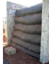
Muro Reforzado c/Geotextil
