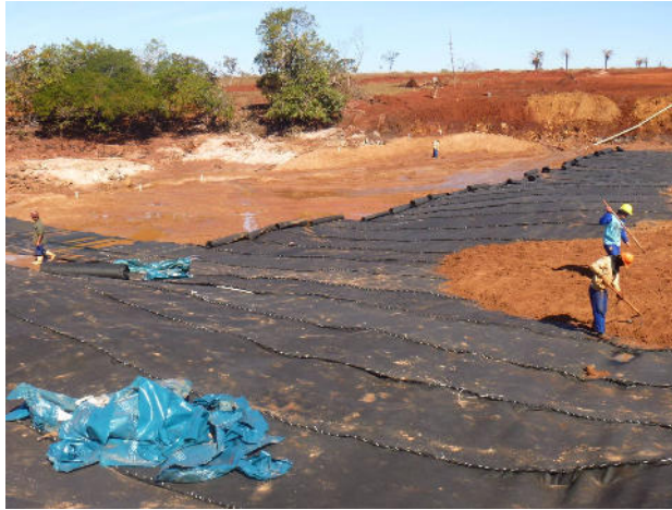
Geocompuesto Drenante en Presa - PCH Pontal do Prata, Goiás, Brasil
