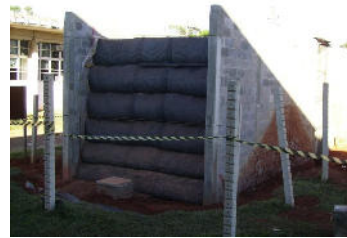
Muro Reforzado c/Geomalla
